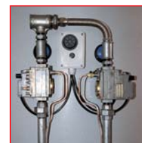
Два электрических клапана позволяют использовать на половину мощности
